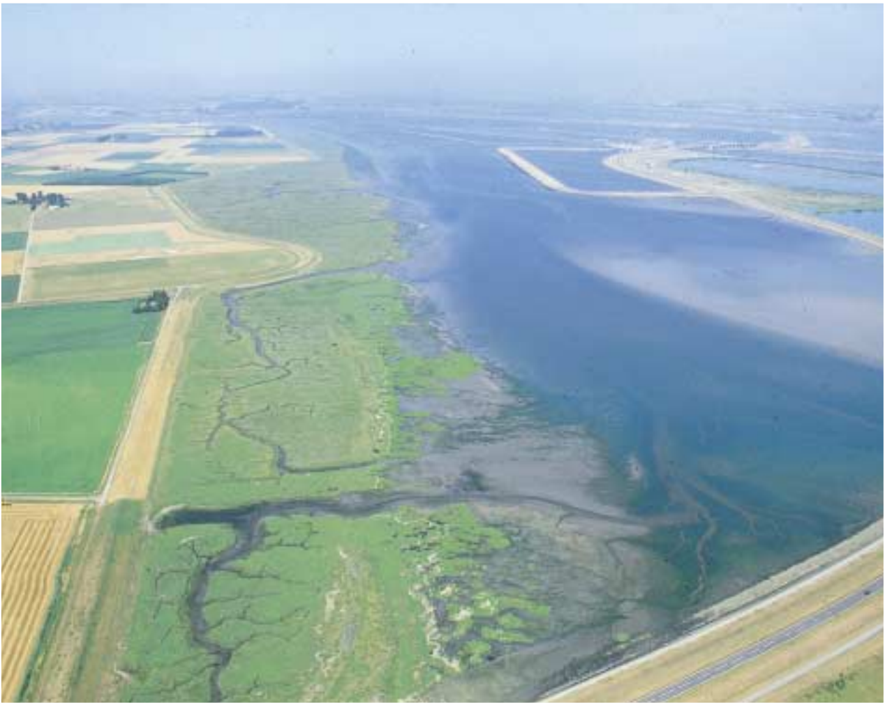
Foto 3 Het schor van Rumoirt in de noord-oostelijke tak van de Oosterschelde, gelegen aan het Slaak in de luwte van de Phillipsdam en de Krammersluizen.
